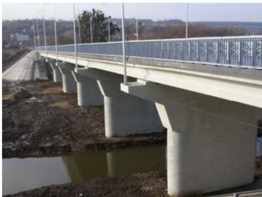
Рисунок 8 – Загальний вигляд мосту на автодорозі державного значення М-12 у м. Гайсин після комплексної реконструкції.
