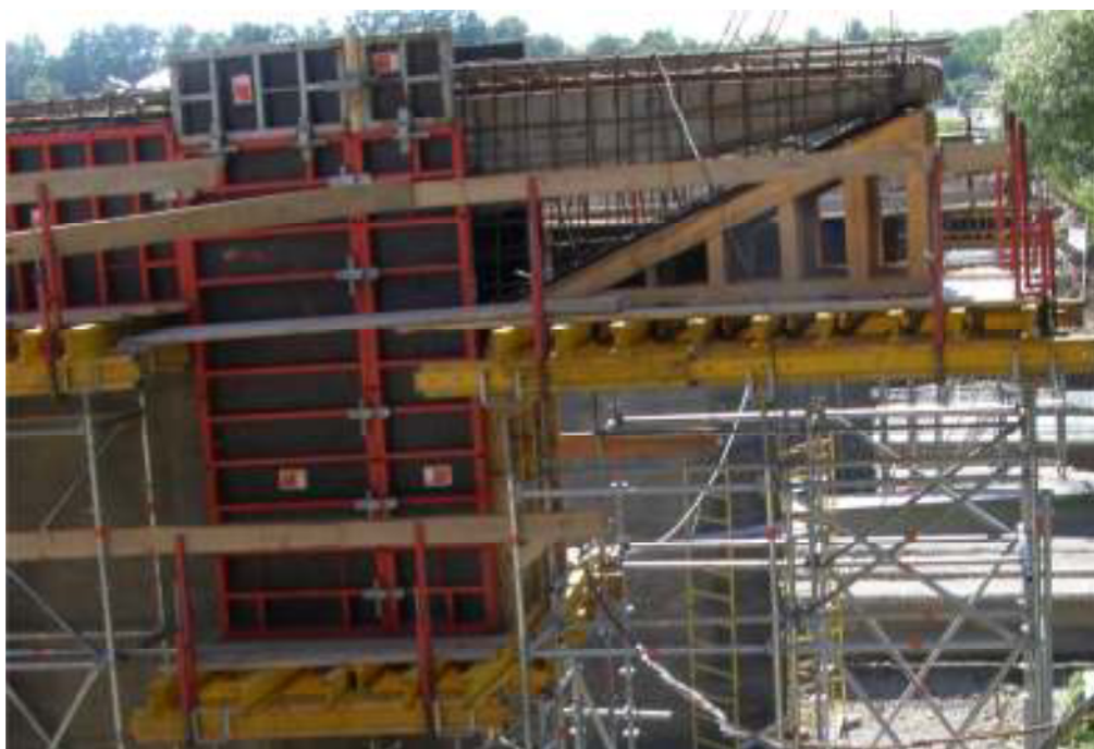
Рисунок 5 – Робоче армування обойми. Встановлення опалубки.
