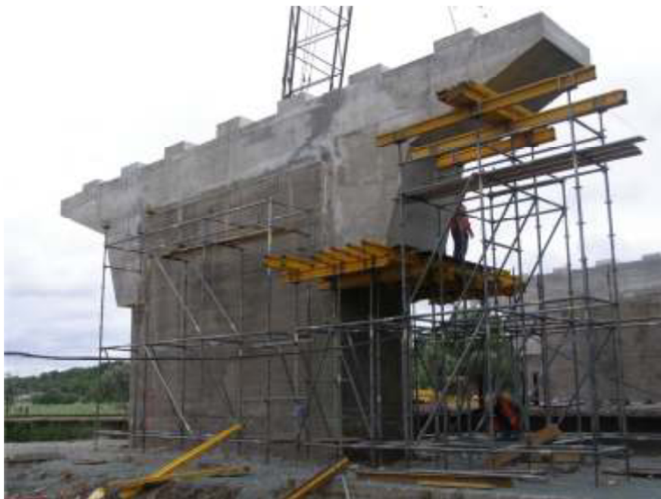
Рисунок 6 – Загальний вигляд мостової опори після підсилення бітрапецеїдальною обоймою.
