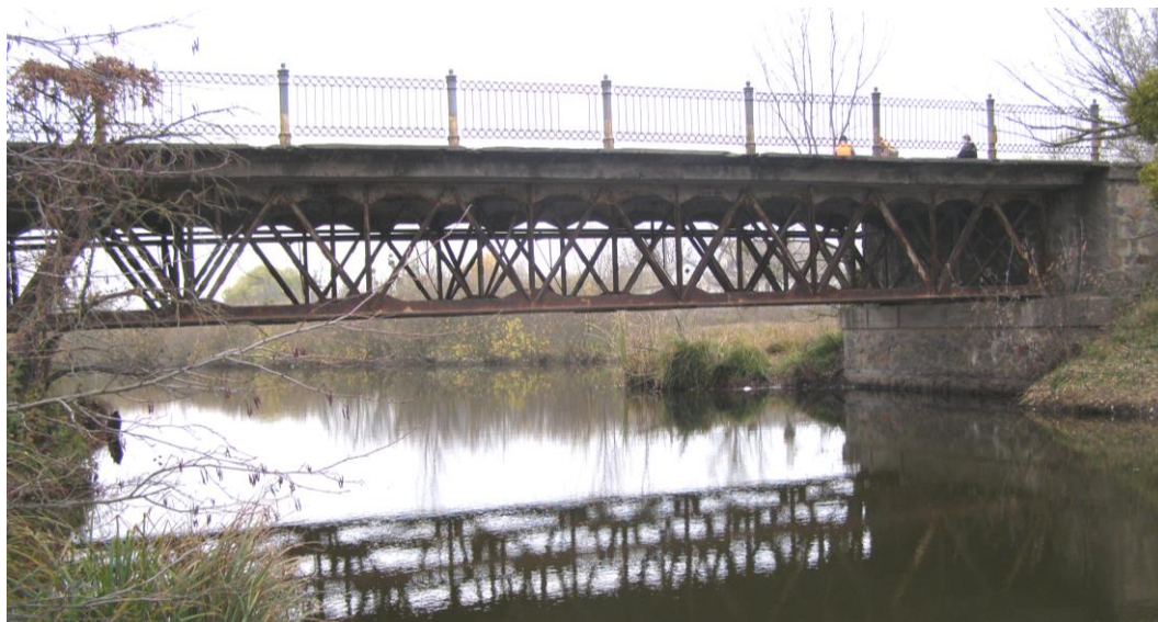
Рис. 1. Загальний вигляд стале залізобетонного мосту у смт. Дашів до реконструкції.
