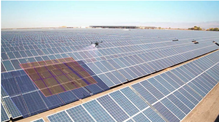
Рисунок 4.10 – Визначення пошкоджених ФЕМ за допомогою квадрокоптеру
