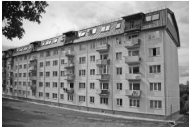
Рис. 1. Схема реконструкції житла з надбудовою мансардного поверху
