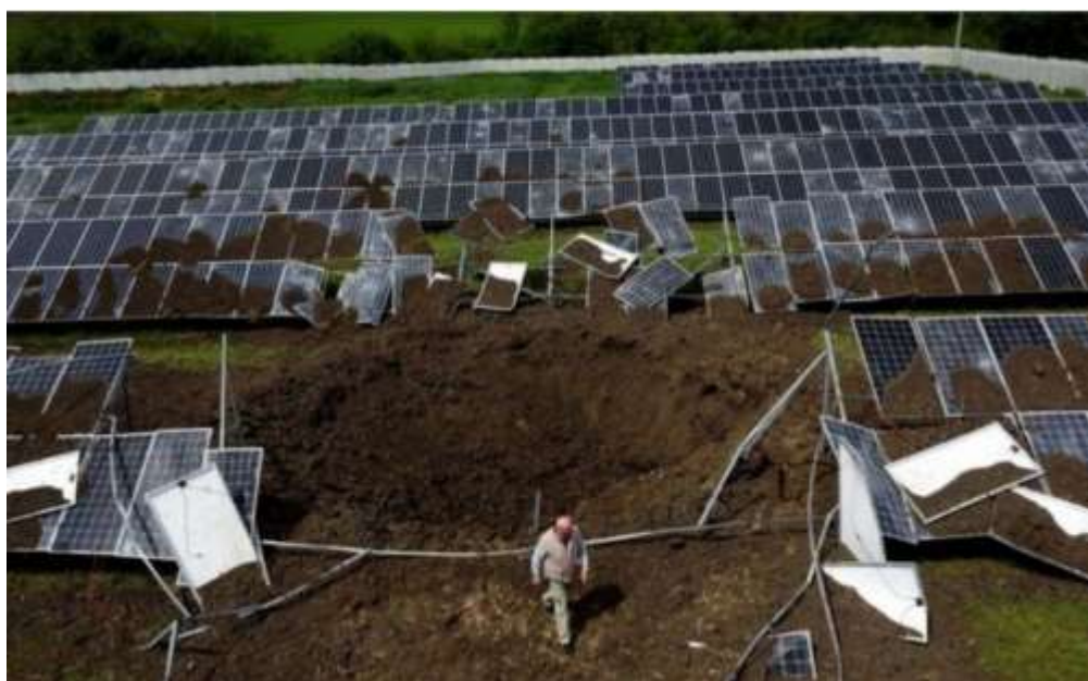
Рисунок 1 - Постраждала від ракетного обстрілу сонячна електростанція компанії Solar Generation у Харківській області – ФЕС "Мерефа" (фото Станіслава Ігнат'єва)
