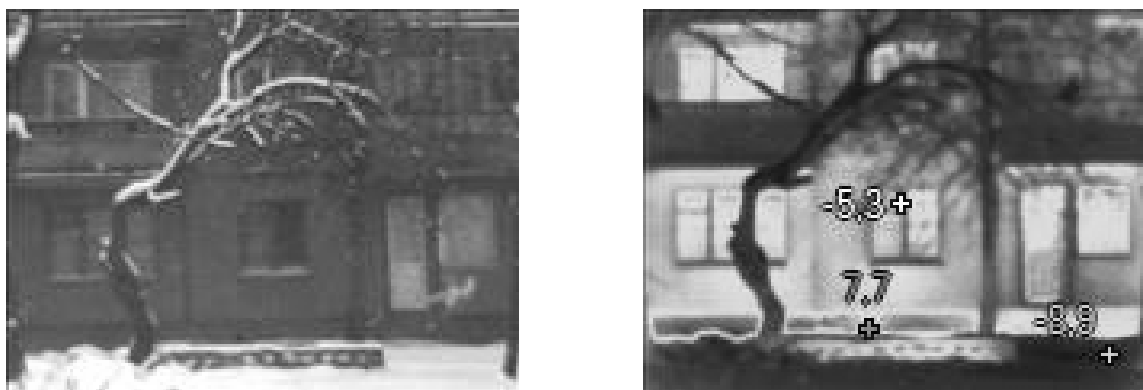
Рис. 1. Тепловтрати через цоколь та віконні прорізи житлового п'ятиповерхового будинку.
