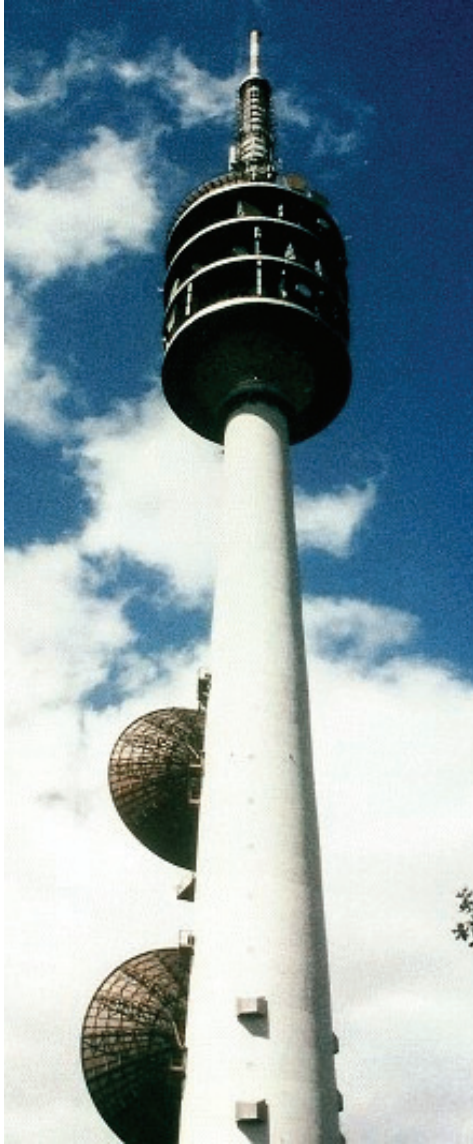
Рис. 1.5. Радіобашта, м. Берлін (збудована 1961–1963 р.р.): висота – 212 м, діаметр основи – 22,16 м, гол. конструктор – А. Г. Хотив [21]
