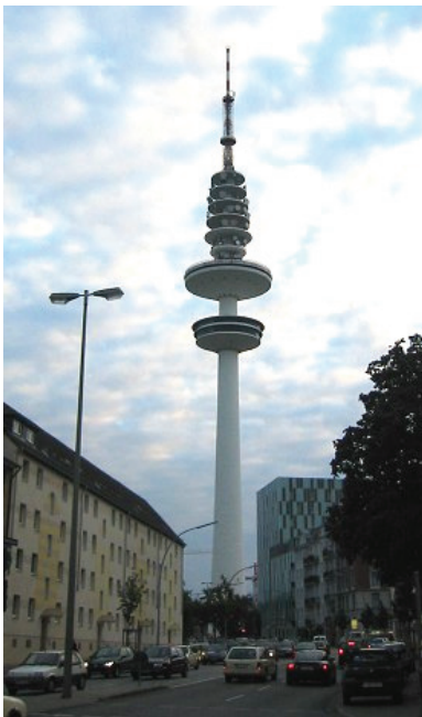
Рис. 1.9. Комунікаційна башта у м. Гамбург (збудована 1968 р.) : висота – 272 м, діаметр основи – 41 м, конструктор – Леонард Фрітц, архітектор – Юрген Слейч [20]
