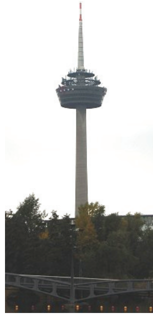
Рис. 1.8. Телебашта у Вестфалені (збудована 1981р.): висота – 266 м, діаметр – 5–14,9 м, конструктор – Леонард Фрітц, архітектор – Ервін Хайнле [24]
