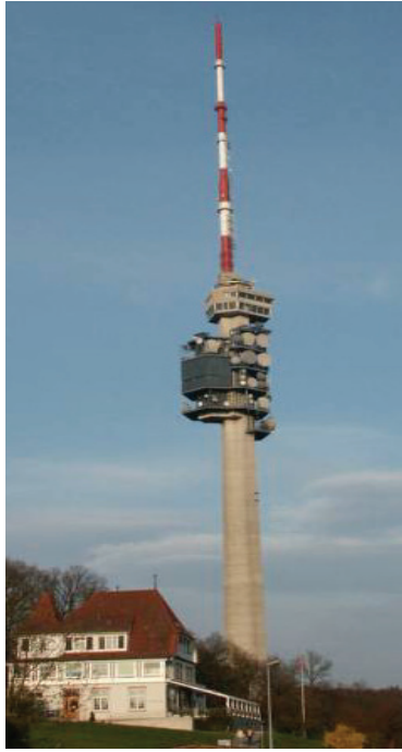
Рис. 1.31. Комунікаційна башта у м. Базель, Швейцарія (збудована 1983 р.): висота – 250 м [20]
