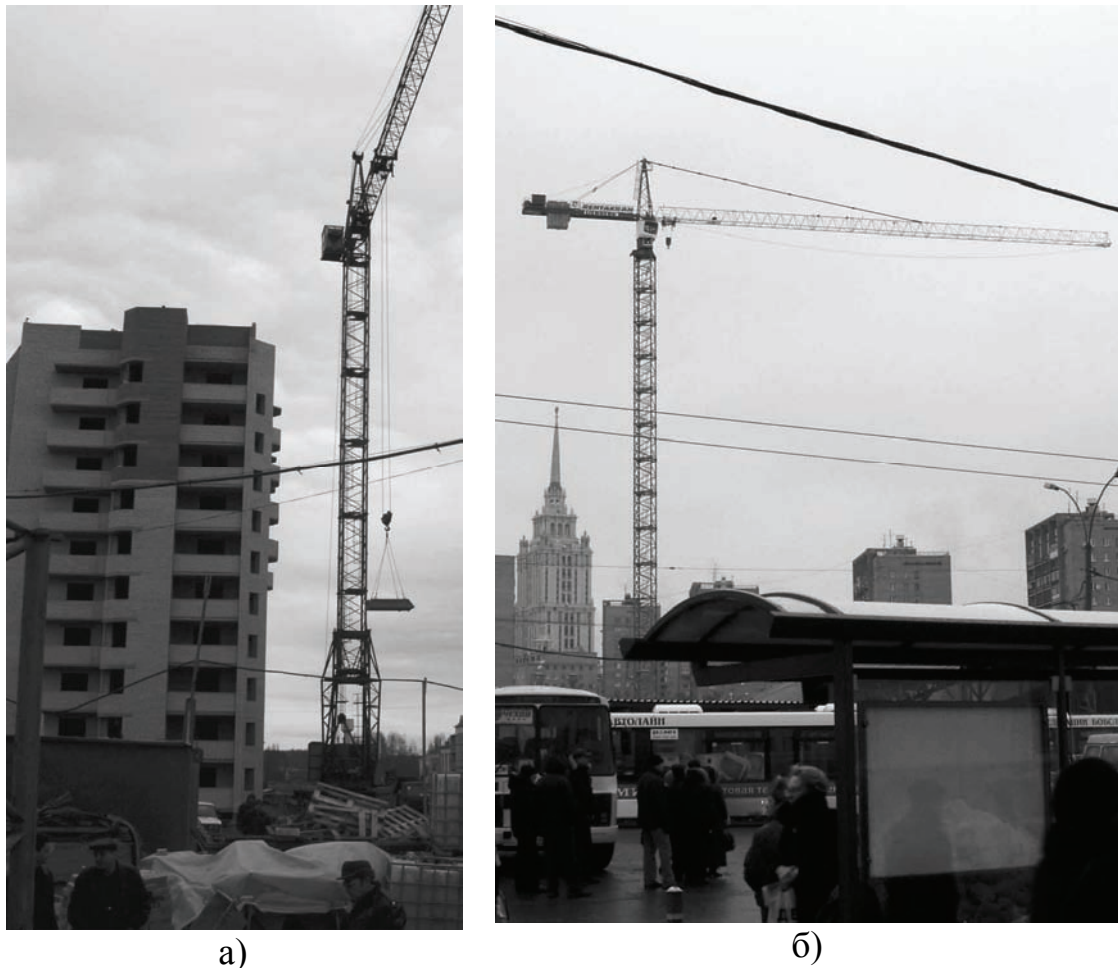
Рис. 1.57. Стівбур баштових кранів: а – вітчизняний КБ-403Б; б – Швейцарський Liebherr 200 EC-H
