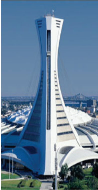
Рис. 1.18. Башта, що підтримує конструкції покриття, у м. Монреаль, Канада (1976 р.) [20]
