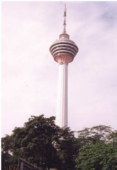
Рис. 1.37. Комунікаційна башта у Коала-Люмпур, Малазія (збудована 1996 р.): висота – 421 м, конструктор – В. Байк [20]
