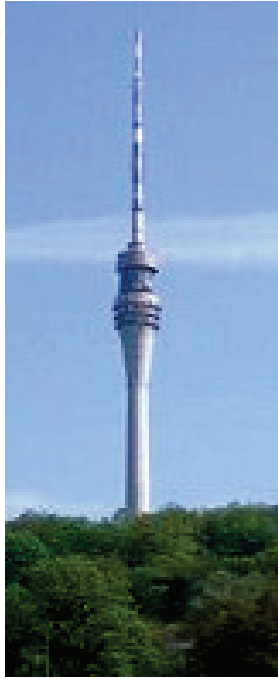
Рис. 1.11. Комунікаційна башта у м. Дрезден (збудована 1963–66 р.) : висота – 252 м, діаметр основи – 41 м, конструктор – Х. Руле, архітектор – К. Новотни [26]
