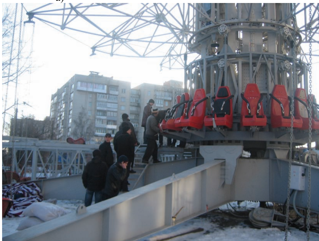
Рис. 3.26. Конструктивне вирішення платформи башти-атракціону на флюгерах та: а – жорсткому осерді з вертикальними фланцями, б – двох горизонтальних діафрагмах, в – конструктивна реалізація попереднього варіанта ТОВ «Сармат» (НВО «Завод Аналог») на атракціоні «Магнетик-XXL»
