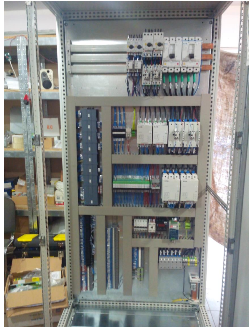
Контролерна шафа під час монтажу
