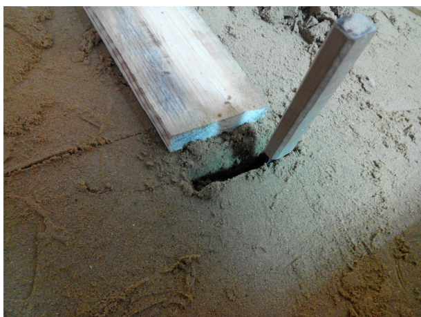
Рис. 1. Влаштування отворів для шлиць
