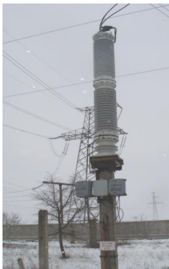
Рис. 1. Конденсатор зв'язку СМА-166/ \sqrt{3} -14 УХЛ1
