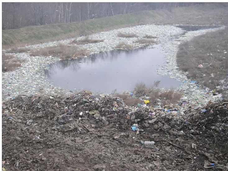
Рисунок 9.5 – Ставок фільтрату Стадницького сміттєзвалища
