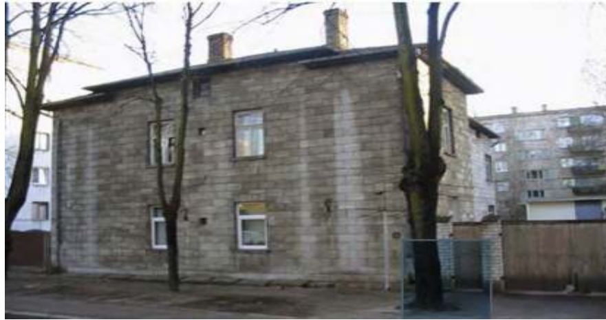
Рисунок 1 – Будівля з автоклавного газобетону без зовнішнього оздоблення побудови 1939 року, м. Рига, вул. Ельвірас,15
