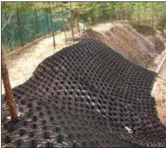
Застосування геоматриць для укріплення укосів ярів
