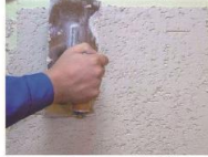
Нанесення і затирання тонкошарової декоративної штукатурки
