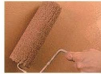
Нанесення ґрунтовки (фарби).
