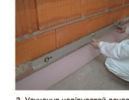
Закріплення цокольного профілю
