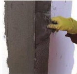
Посилення кутів захисним профілем і склотіткою
