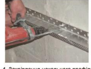
Закріплення цокольного профілю
