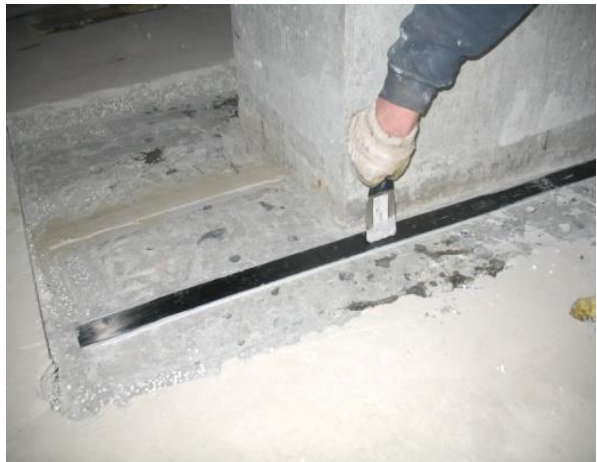
Рис. 9. Виконання посилення припорних зон плити по верхніх гранях вуглецевими стрічками
