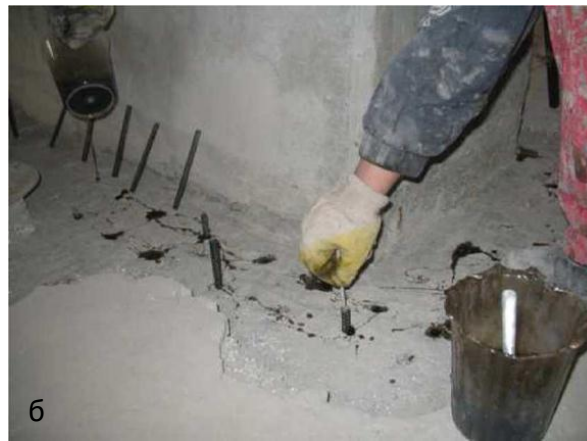
Рис. 8. Втоплення стержнів в припорній зоні: а - підготовка стержнів (грунтування); б - втоплення стержнів у шпури на клею ЕДМОК
