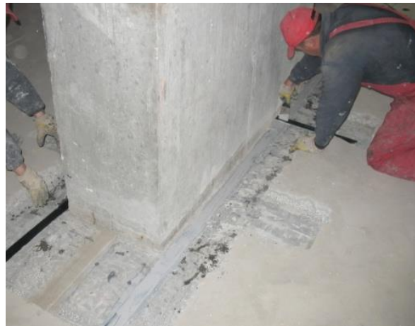
Рис. 9. Виконання посилення припорних зон плити по верхніх гранях вуглецевими стрічками
