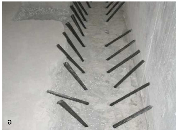
Рис. 8. Втоплення стержнів в припорній зоні: а - підготовка стержнів (грунтування); б - втоплення стержнів у шпури на клею ЕДМОК
