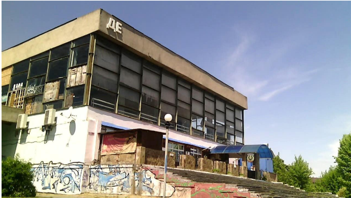
Рис.2 Центральний фасад кінотеатру у 2018 році
