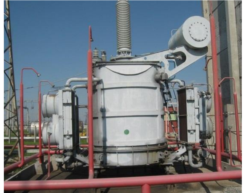
Рисунок - Шунтируючий реактор РОДЦ-60000/500 У1
