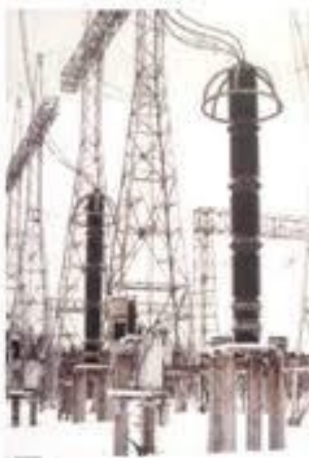
Рисунок – Трансформатор напруги типу НДЕ-500-72У1
