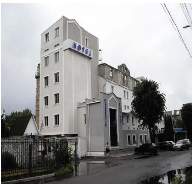
Рис. 3- Стан готелю «Добродій» до реконструкції
