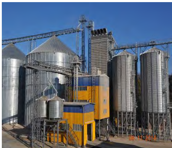
Рисунок 1 – Зерносушарка шахтного типу
