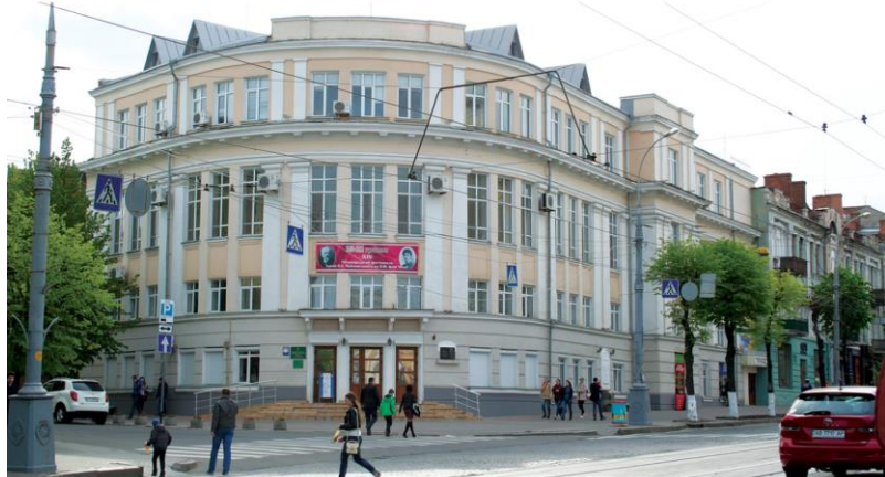
Будівля ВОУНБ ім. К. А. Тимірязєва (гоголівська читальня), вул. Соборна, 73. Фото автора, 2018 р. Пам'ятка місцевого значення, охоронний номер 373-Вн
