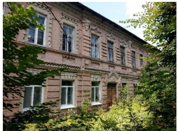
Рис. 3.37 Казарми, вул. Стрілецька, 19 (1886р., арх. К. Пруссак). Фото автора, 2019 р.
