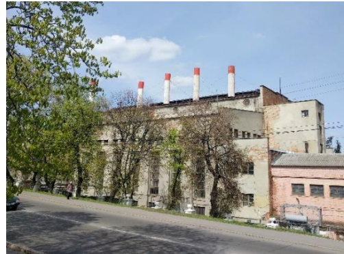
Рис. 4.20 Електростанція, вул. Магістратська, 44 (1932 р.). Фото автора, 2018 р.
