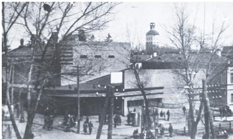
Кінотеатр ім. Коцюбинського (реконструкція 1958 р.), вул. Соборна, 68, 1931 р. (ДАВіО. Оп. 9616). Щойно виявлені об'єкти (2007 р.)
