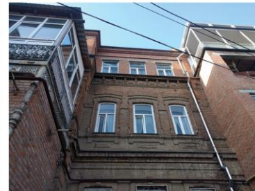
Дворовий фасад (фрагмент)
