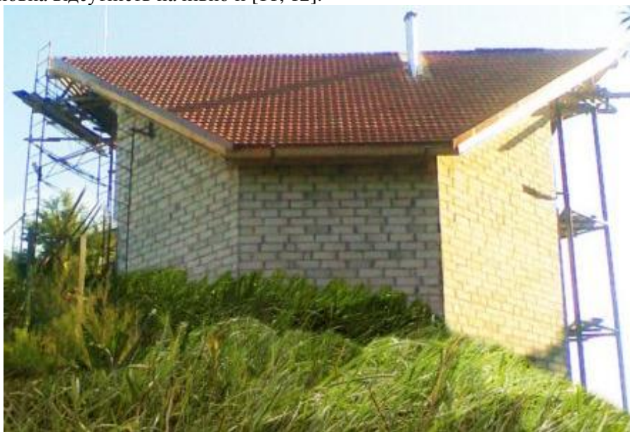
Рис. 2 Приклад глухого фасаду з північної сторони (пасивний будинок Чернігівська обл.)
