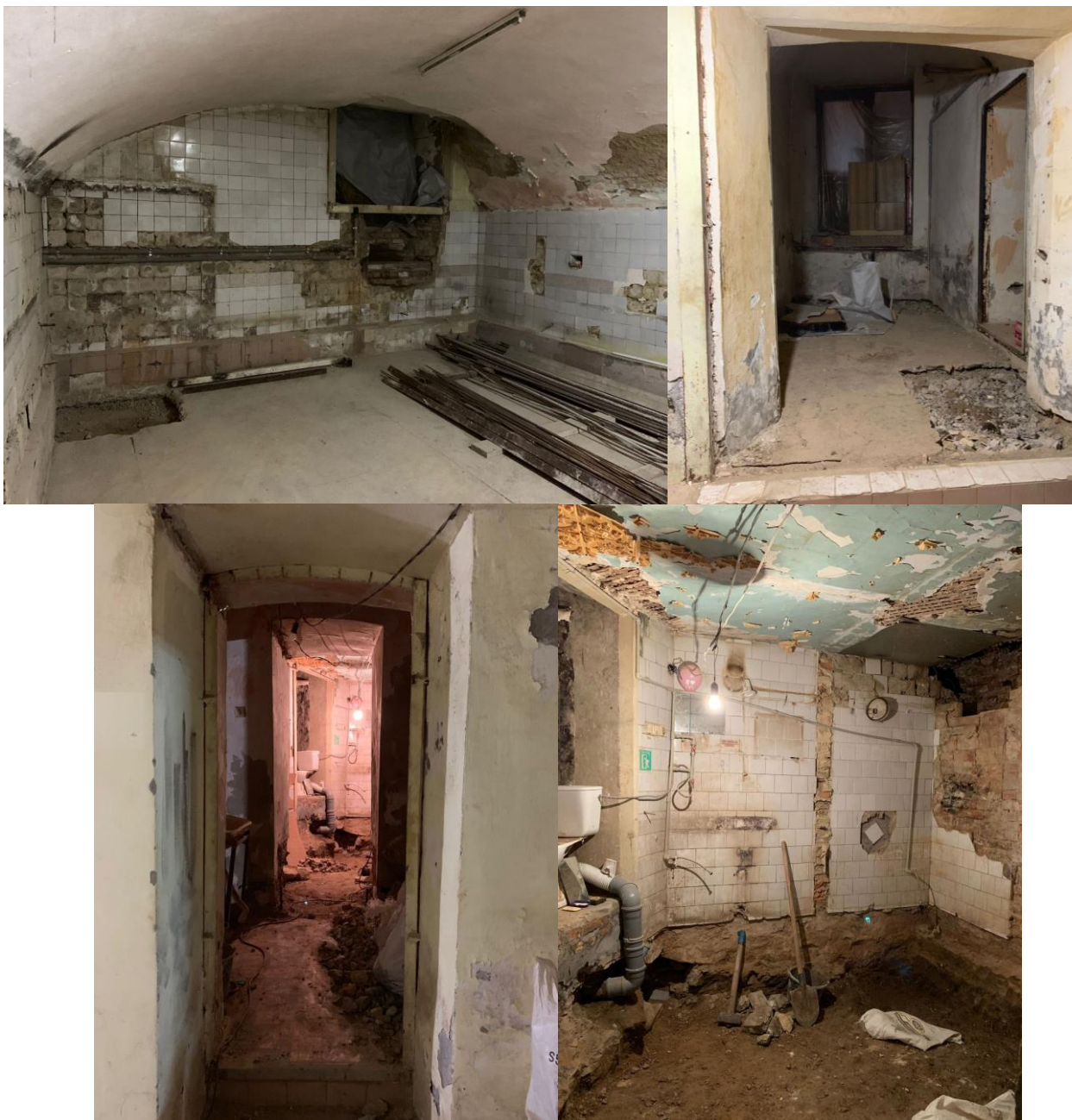
Рисунок 1 – Фотофіксація стану підвального приміщення колишньої пекарні до ревіталізації
