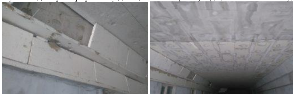
Рис. 3. – Утеплення висотного житлового будинку
