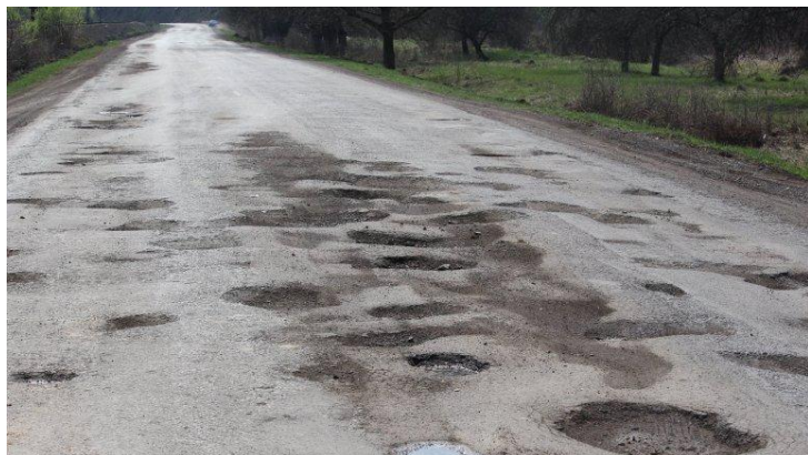
Фрагмент дороги зі зруйнованою поверхнею
