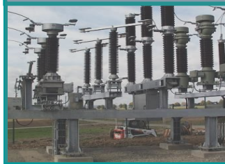
Модульная ячейка SIMOBREAKER
