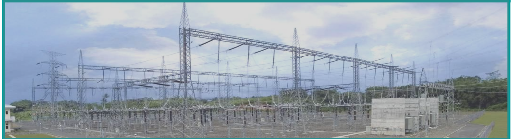
Распределительные устройства с воздушной изоляцией
