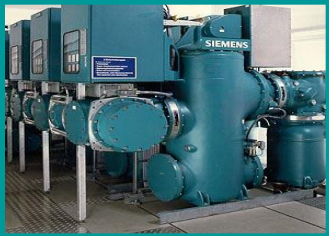
Розподільні пристрої з елегазовою ізоляцією КРУЕ
