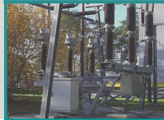
Выкатной выключатель SIMOVER®
