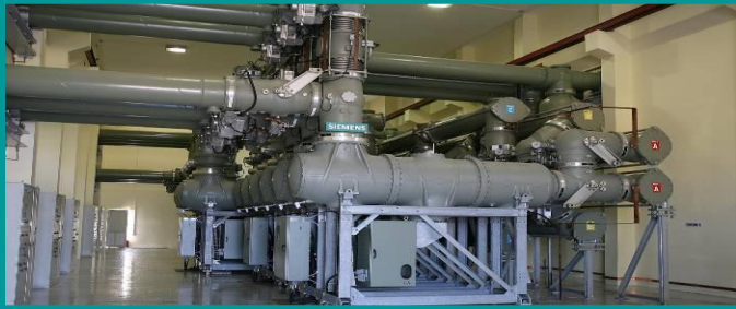
Розподільні пристрої з елегазовою ізоляцією КРУЕ
