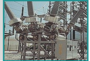
Ячейка с баковым выключателем
