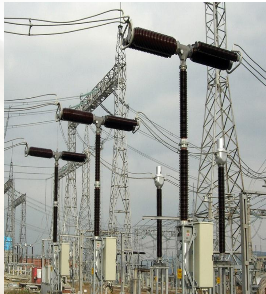
Колонковий елегазовий вимикач типу HPL
