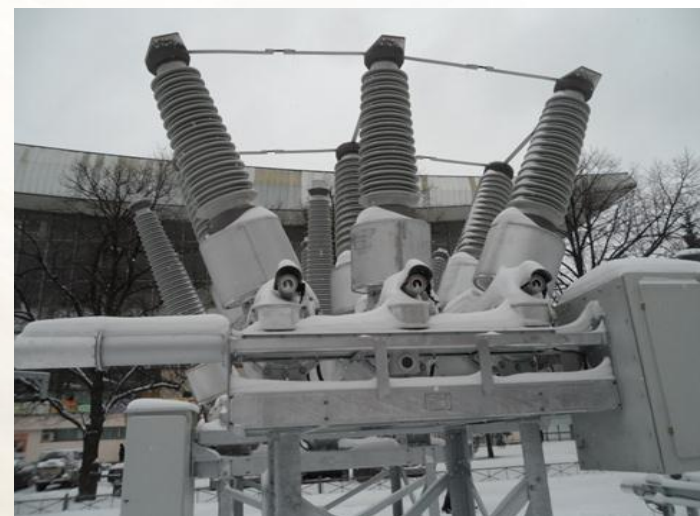
Елегазовий вимикач з датчиками щільності
