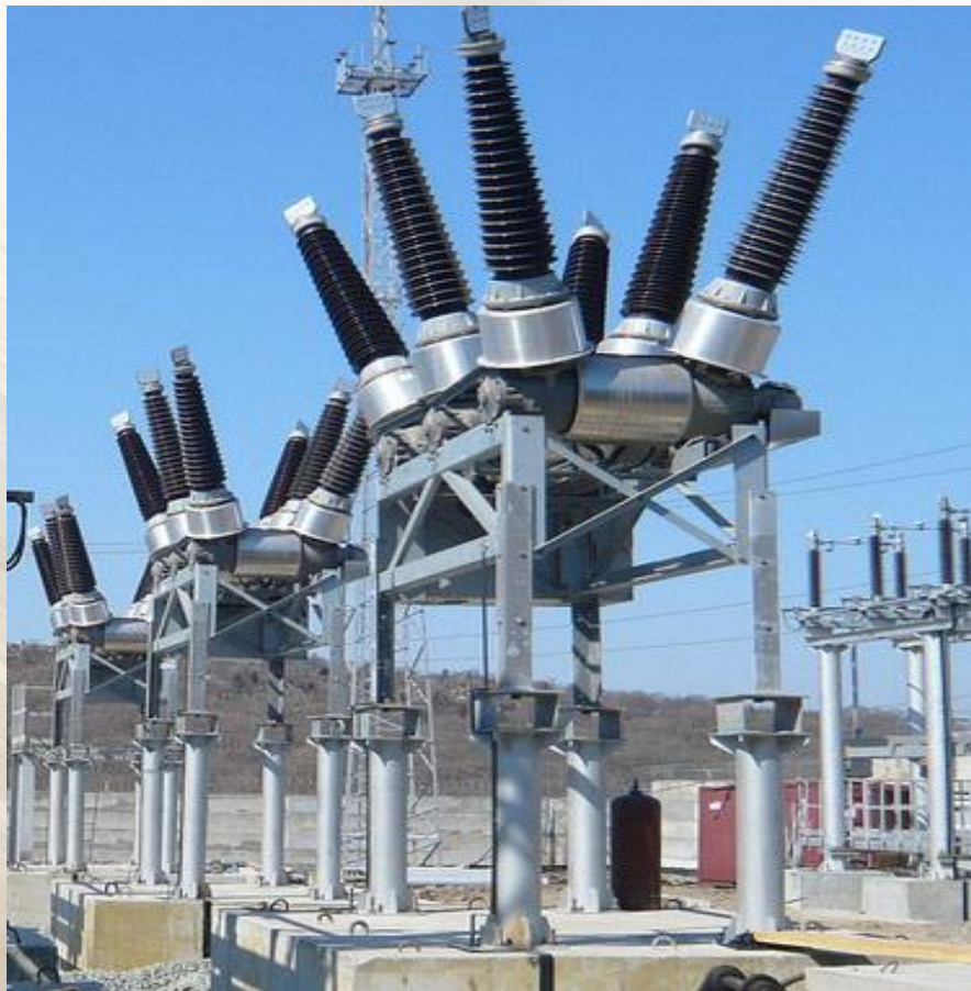
Баковий елегазовий вимикач ZAP1 DT-145EK
