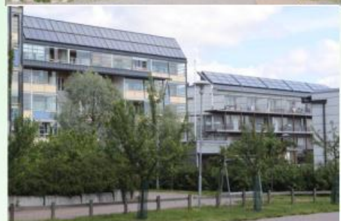
Сонячні колектори вбудовані в конструкцію даху житлового будинку і встановлені під кутом 47-60°
