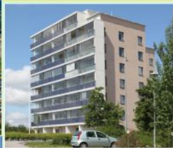
Встановлення фотоелектричних панелей на балконах багатопверхових будинків
