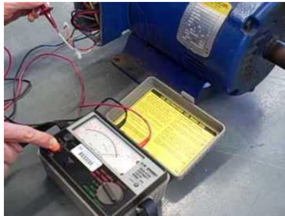
Рисунок 7.4. Вимірювання мегомметром опору ізоляції електричного двигуна
