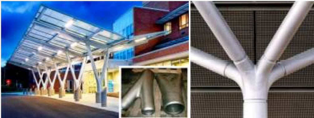
Рисунок 3 - Застосування сталевих вузлів в опорах навісу перед входом у шпиталь, а також на трубчастій просторовій конструкції на колоні [9].
