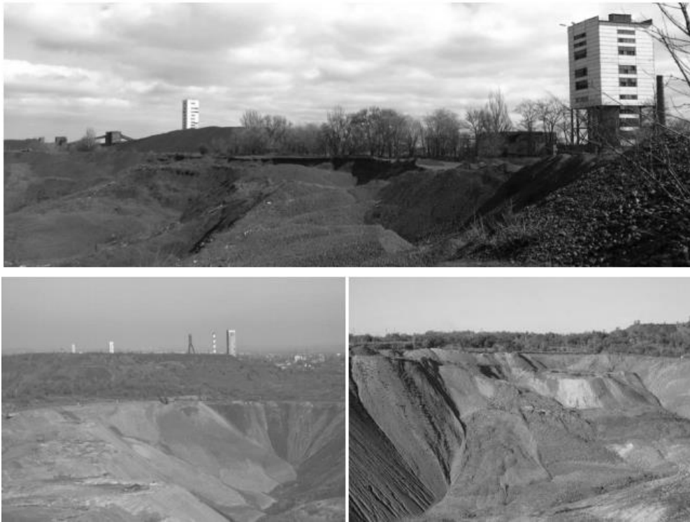
Рис.1.1.Засипка Глеюватського кар'єру ВАТ ЦГЗК пустою породою, Кривий Ріг [2]
