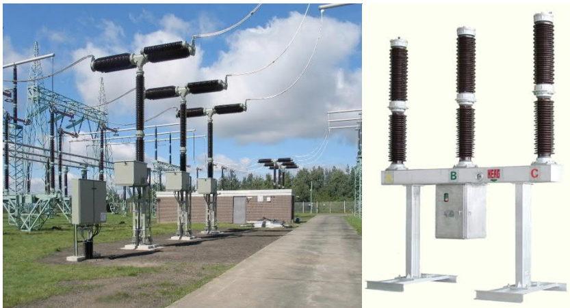
Рис. 1. Елегазовий вимикач на 110 кВ
