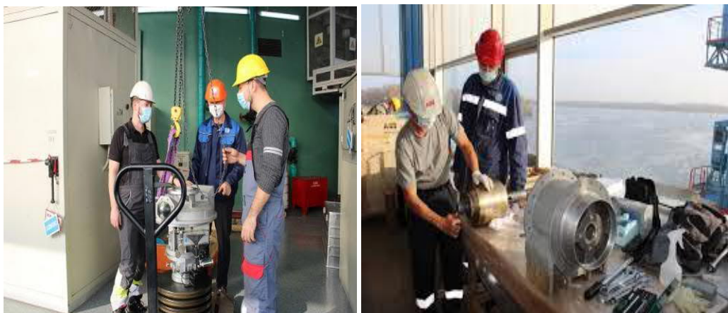
Рис. 3. Ремонт елегазового високовольтного вимикача
