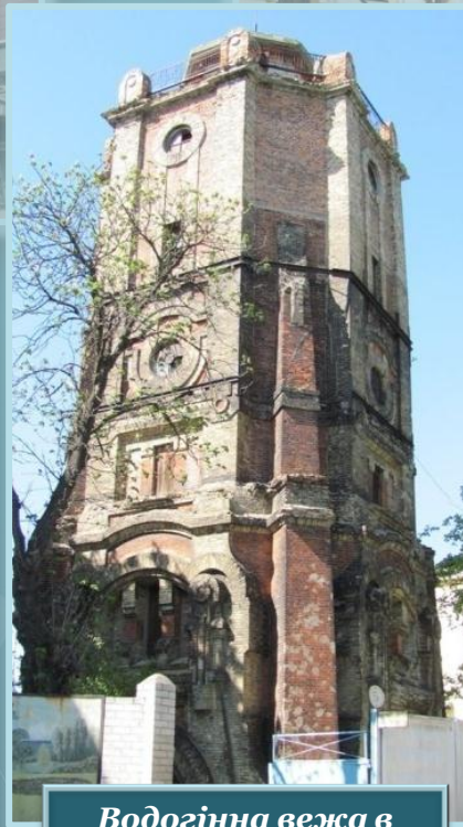
Водогінна вежа в Козятині
