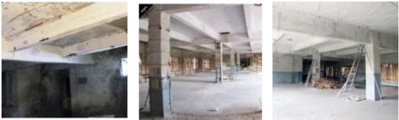
Рис. 1. Загальний вигляд об'єктів випробувань
