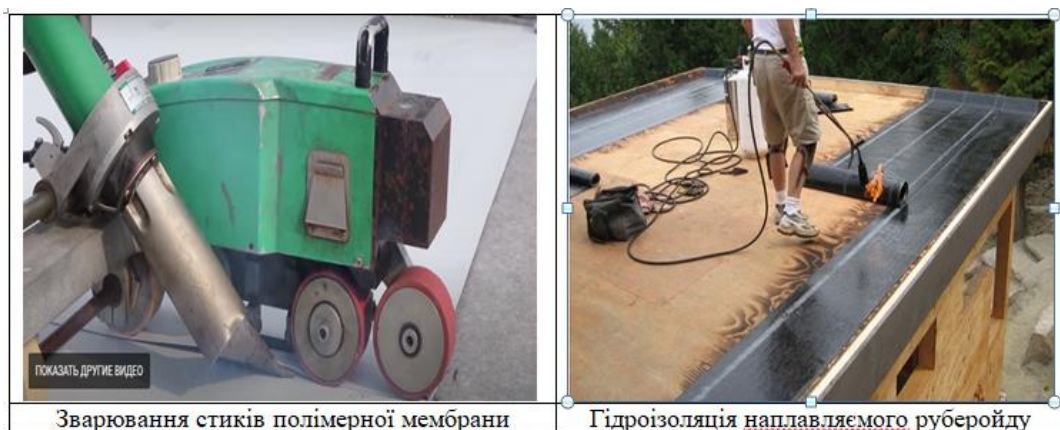
Рис. 3. Принципові технологічні схеми влаштування гідроізоляції при влаштування інверсійної покрівлі.
