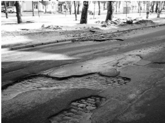
Рис. 3. Вибоїни на дорогах
