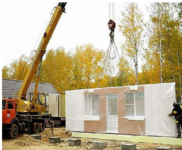
Рис. 2 – Монтаж каркасно-панельного будинку
