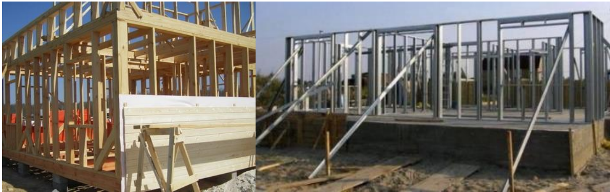
Рис. 7 – Дерев'яний і металевий каркаси каркасно-рамних будинків
