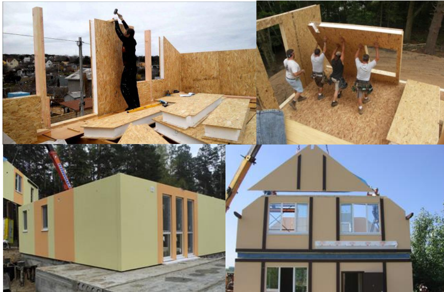
Рис. 6 – Монтаж житлового будинку із СІП-панелей
