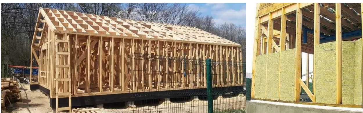
Рис. 3 – Проект каркасно-щитового житлового будинку
