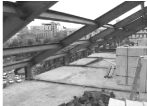
Рис. 4. Монтування мансардного поверху. Установка металевих рам м. Київ.
