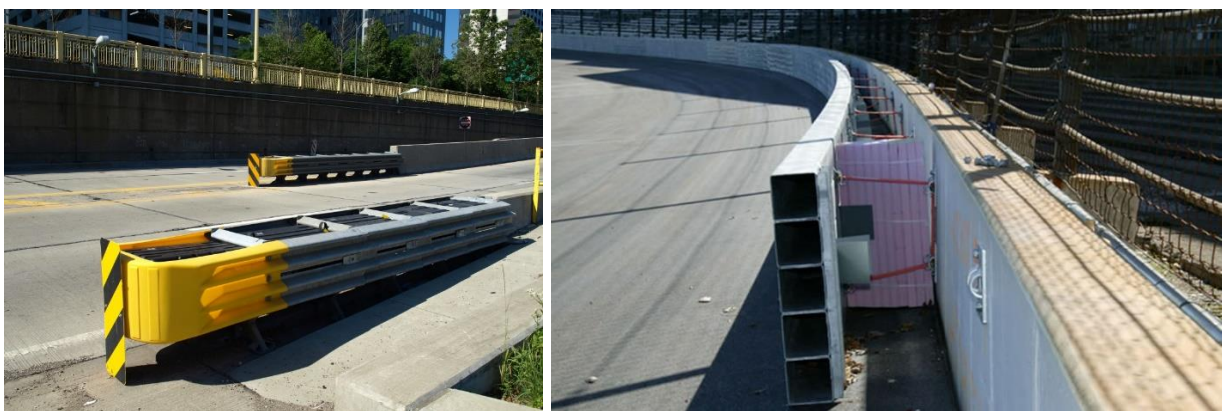
Рисунок 1 – Дорожнє огородження на основі сталевих енергопоглинальних елементів.
