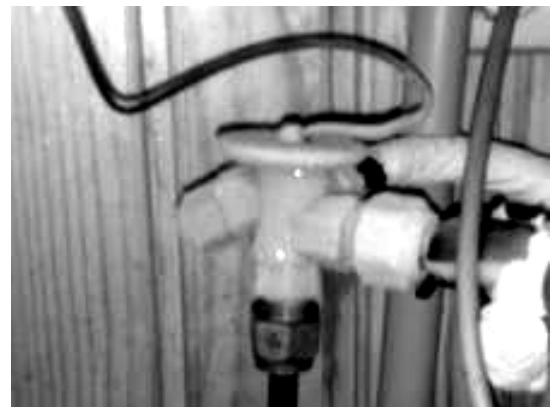
Рис. 4. Приклад візуальної діагностики: обмерзання ТРВ
