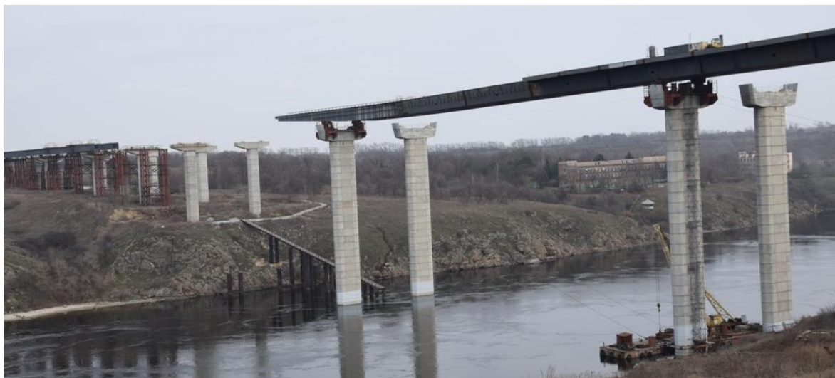
Рис. 1. Будівництво мосту методом насунання у м. Запоріжжі.
