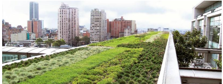
Рис. 3. Екстенсивні зелені покрівлі
