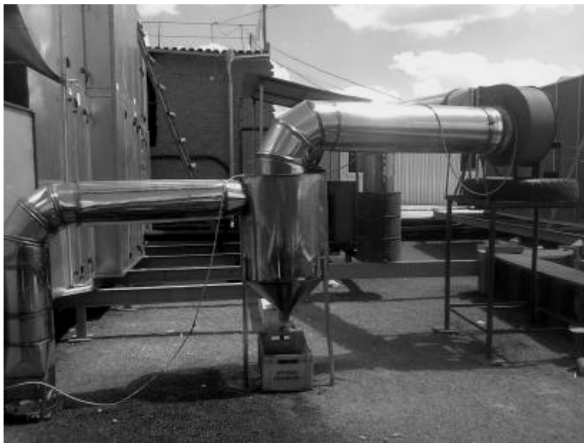
Рис. 5. Реалізована енергозберігаюча система очищення вентиляційних викидів використовується при виробництві цукрового сиропу
