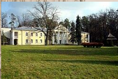
Лікувально-приймальний корпус (водолікарня) 1948–1949 рр.
