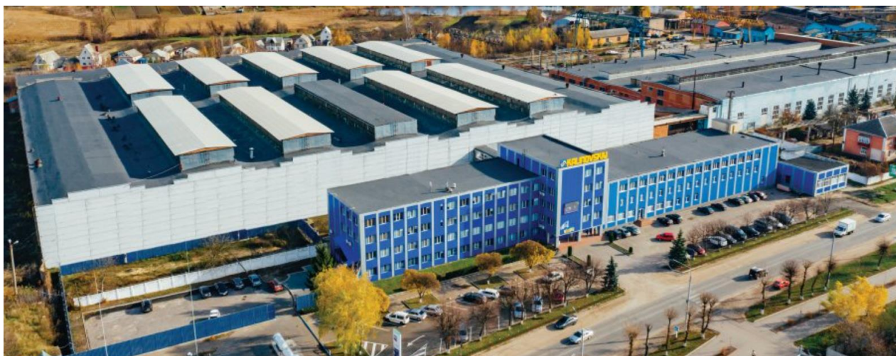
Рис. 2. Калинівський машинобудівний завод з висоти
