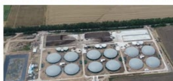
Рис. 48.1. Перша черга біогазової установки на 10 МВт.
