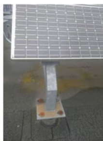
Рис. 30.1. Пошкодження каркасу ФЕМ (пошкодження герметика, пошкодження рамки, пошкодження кріплення).
