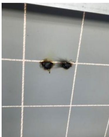
Рис. Б.12. Помилки монтажу та значне вигинання каркасу ФЕМ.
