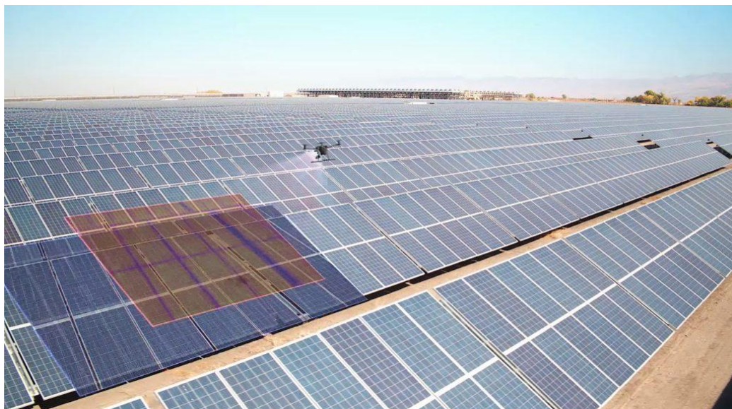
Рис. 4.10. Визначення пошкоджених ФЕМ за допомогою квадрокоптеру.
