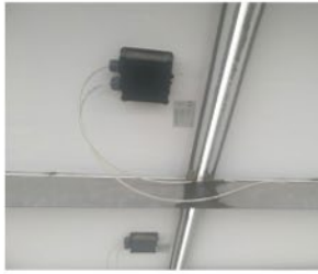
Рис. 31.1. Клемний термінал junction box – місце можливого перегріву.
