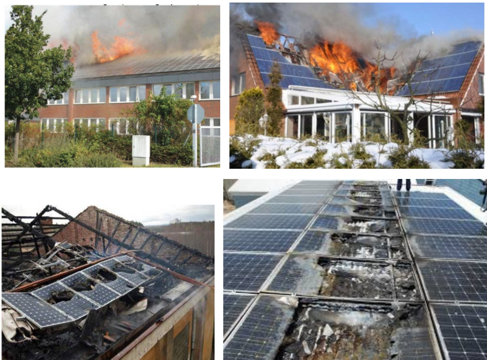
Рис. Б.16. Результати пошкодження ізоляції та контактних з'єднань.
