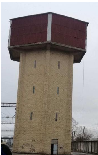
Рис.1. Фото водонапірної вежі.
